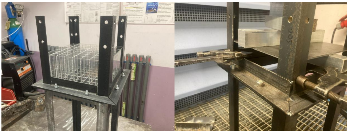
Figure 9 — Fabrication du convergent : (a) mise en place avec conditionneur d'écoulement et vissage avant pointage, (b) utilisation des gabarits pendant le soudage
